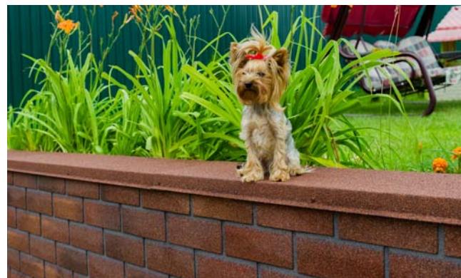
Рис. 69. Оформление подпорной стенки
