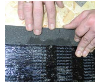
Рис. 74. Насечка для облегчения монтажа
