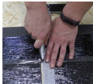
Рис. 75. Деление плитки на лепестки
